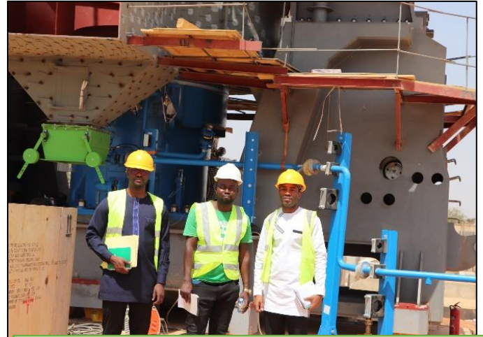
GCM INDUSTRIES SA intervenant dans la Production de Ciment à Ouagadougou
